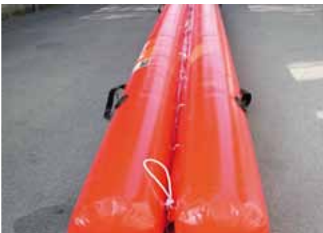
Les deux tubes doivent être bien serrés avant de recevoir le monotube - The two tubes must be tight correctly before to receive the monotube
