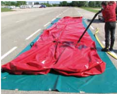
Remplir d'air le tube Filling the tube with air
