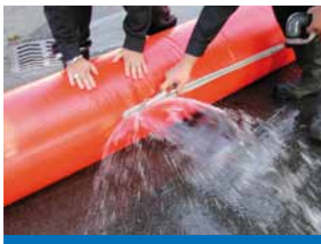
Ouverture de la fermeture éclair une fois que le barrage n'est plus sous pression - Opening of the zip when the boom is not under pressure
