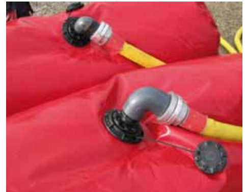
Remplissage de 2 tubes à l'eau Filling of the two tubes with water
